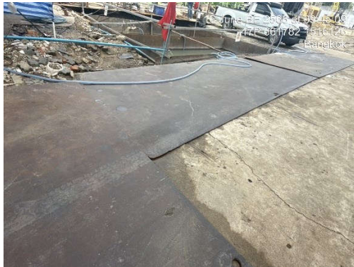
รูปที่ 18 การปูแผ่นเหล็กในพื้นที่ก่อสร้าง
