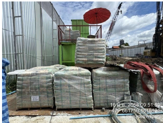
รูปที่ 50 ปิดคลุมวัสดุก่อสร้าง
